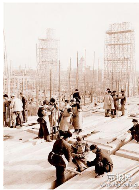
人民大会堂建筑工地
